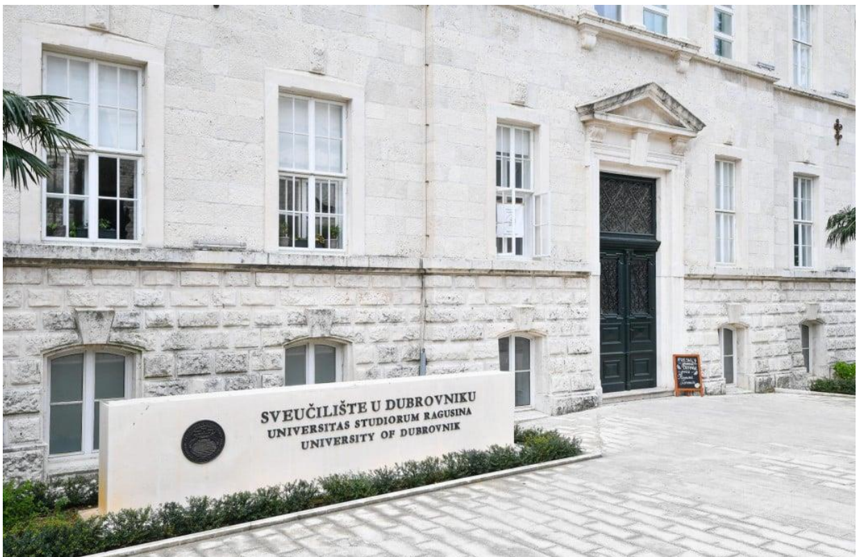
Sveučilište u Dubrovniku (Branitelja Dubrovnika 41)
